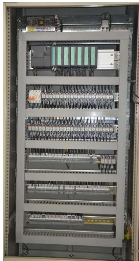
未采用预接线模块Plc输入输 出128点，只做了48点隔离
