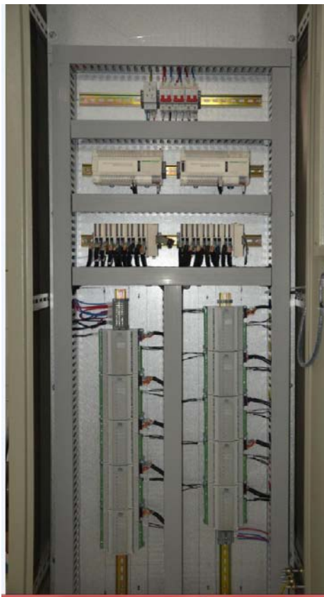
采用预接线模块Plc输入 输出160点，全部隔离
